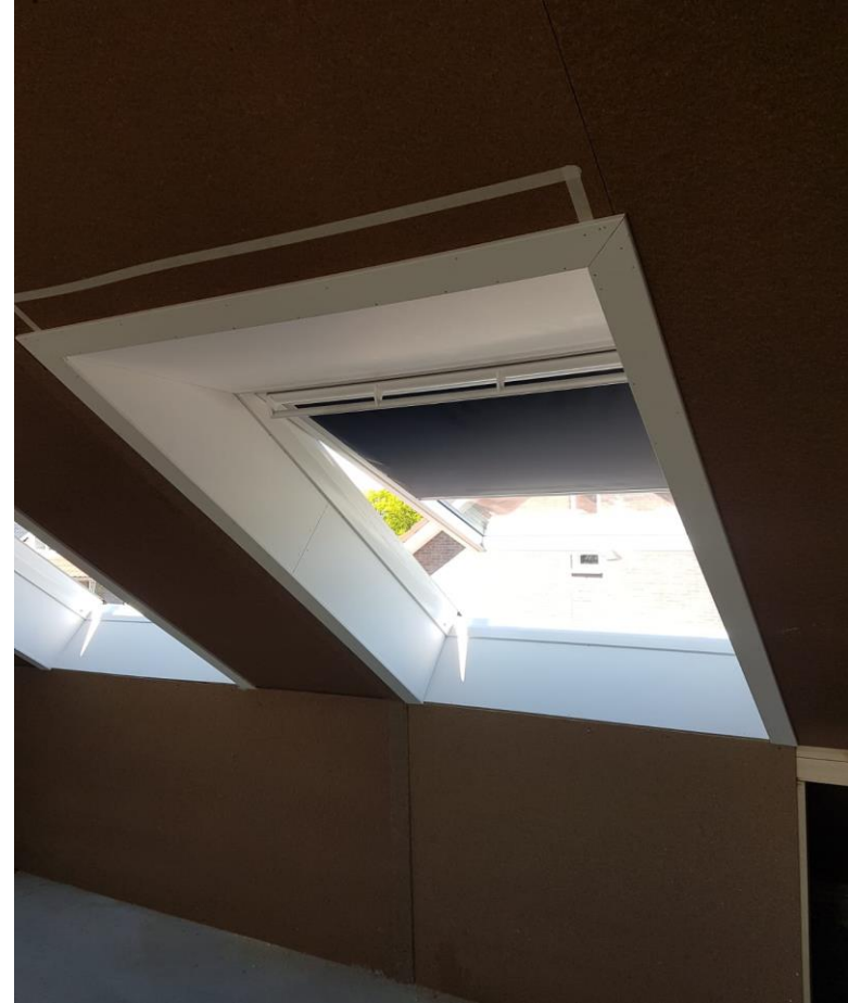
Los uitzet-tuimeldakraam, boven schuin, onder haaks afgetimmerd
