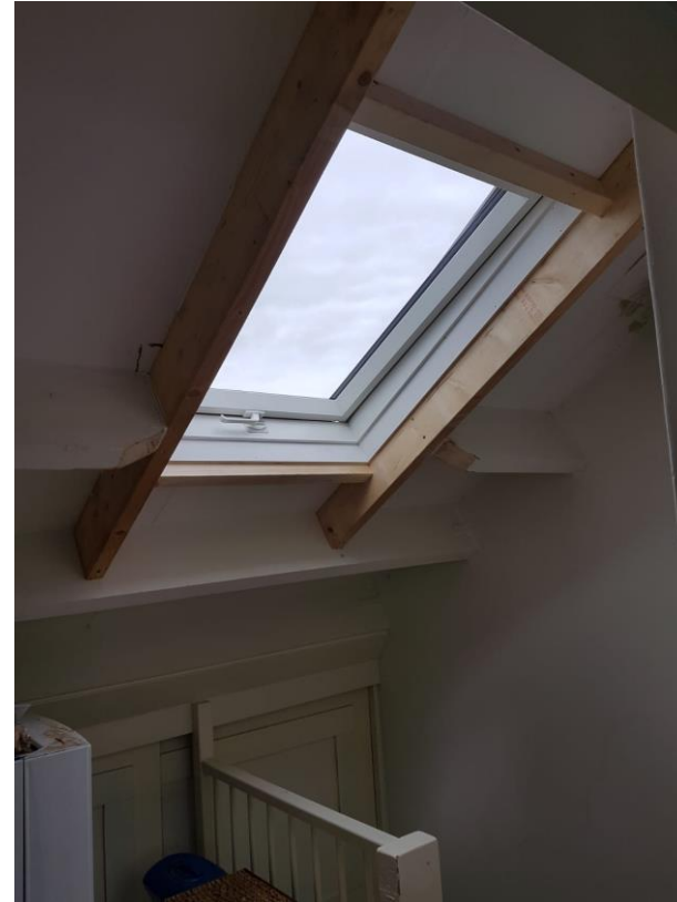
Los dakraam, gordingen doorgehaald en opgevangen
