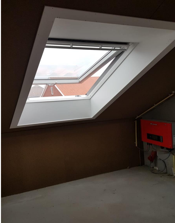
Los uitzet-tuimeldakraam, boven en onder schuin afgetimmerd
