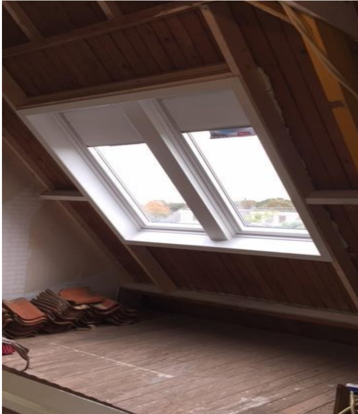
2 gekoppelde dakramen, haakse aftimmering
