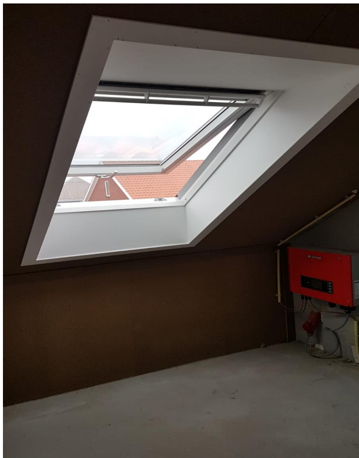
Los uitzet-tuimeldakraam, boven en onder schuin afgetimmerd
