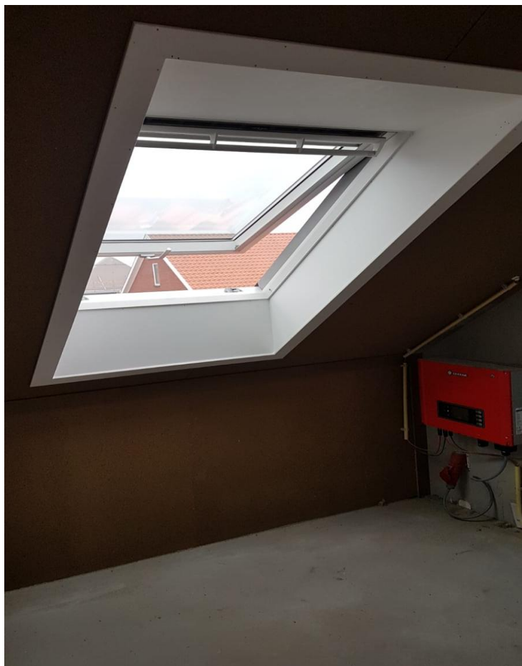
Los uitzet-tuimeldakraam, boven en onder schuin afgetimmerd
