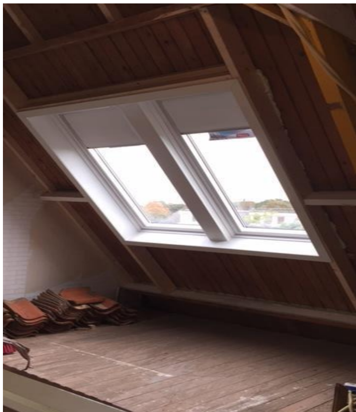
2 gekoppelde dakramen, haakse aftimmering
