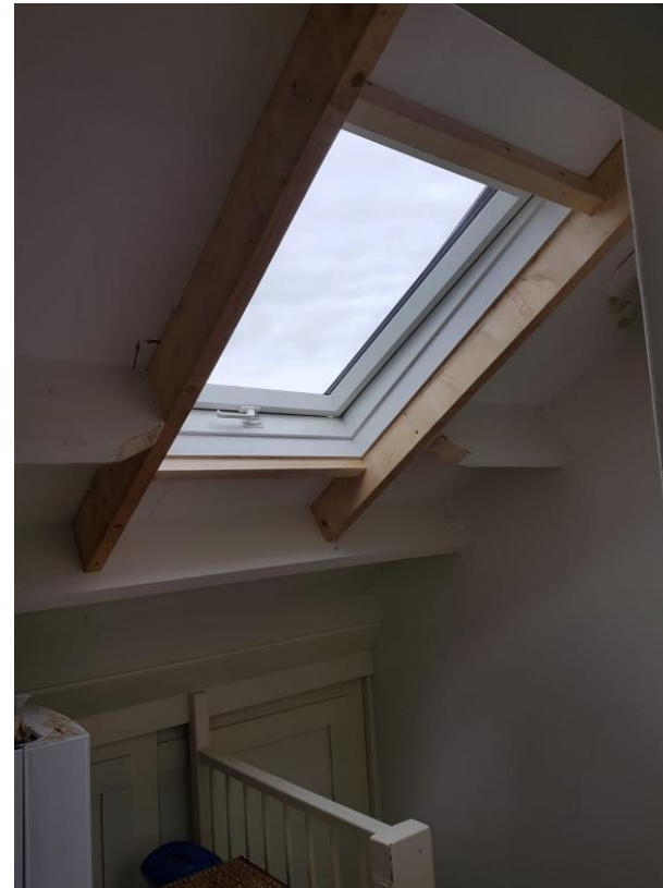
Los dakraam, gordingen doorgehaald en opgevangen
